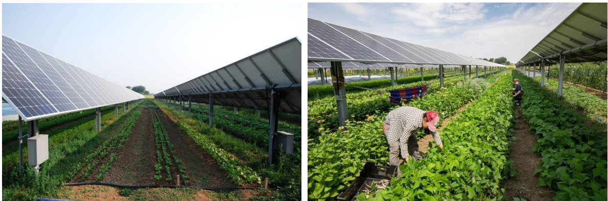
Εικόνα 2: Μονοπάσσαλος Μονοαξονικός ιχνηλάτης.
